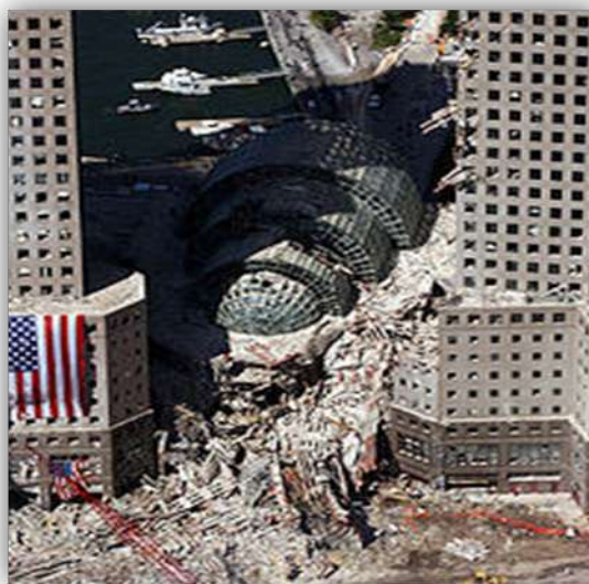
Derrumbe del Complejo World Trade Center 1
