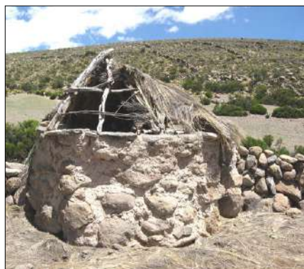
Figura 12: Imagen de la estructura circular, con detalles constructivos
