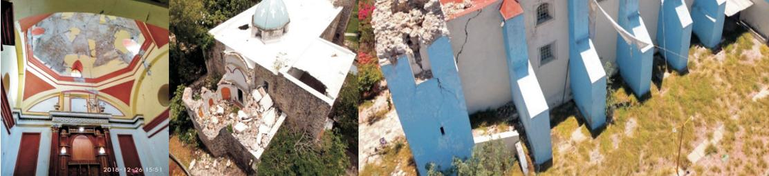
**Figura 3.** Tabla con un recuento de daños por los sismos del 2017 por estado e imágenes de daños generados en inmuebles históricos en el sur del estado de Puebla
