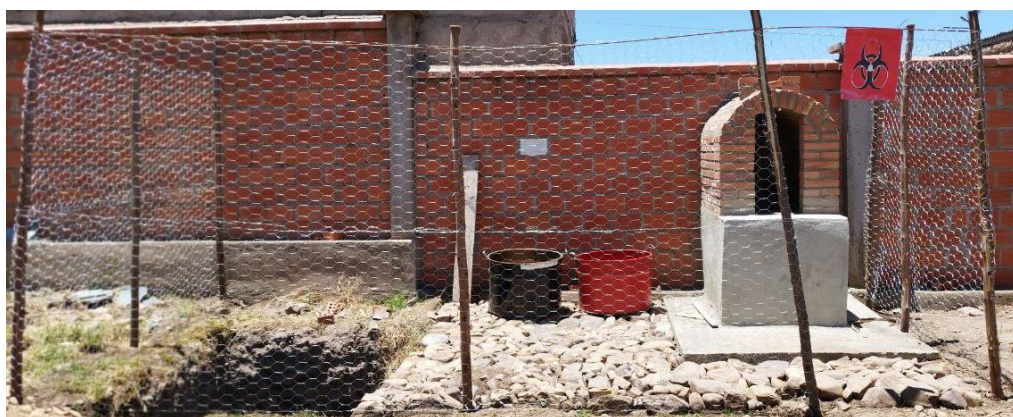
Figura 5. Horno artesanal de incineración implementado en el Centro de Salud Lacaya
