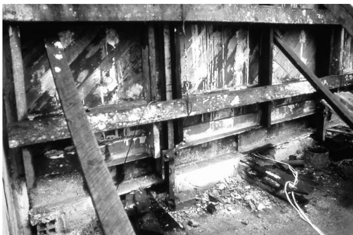
Detalle del mural Huelga cubierto con el gran tablero de madera y rejilla interior de acero. En la parte inferior se aprecia la viga de acero cortada en secciones, con las soldaduras de unión y placas de refuerzo.
