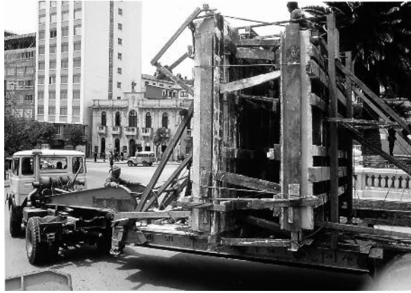
Los dos encofrados con los murales en sus muros, sobre la plataforma plana del camión, en el momento del traslado, pasando por la plaza del Estudiante. Es apreciable el sistema de apoyos de los murales entre sí y con la plataforma, y el sistema de cables de acero que los sujetaban con firmeza.
