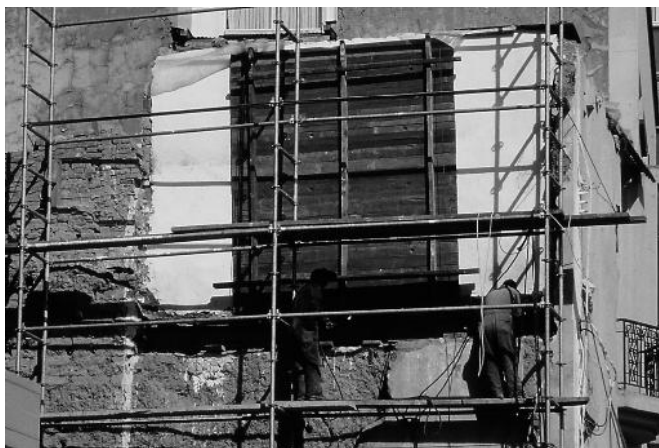
El muro sur del salón, con el mural Masacre , ya adelgazado desde atrás y planchado con estuco, con el segundo gran tablero de madera para protegerlo por la espalda.
