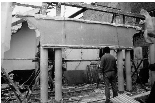
El friso mayor del salón ya el suelo, cubierto con el tablero protector de madera, cinchado con flejes.
