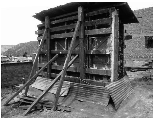
Los dos murales encofrados, después del rescate, colocados sobre podios de concreto, apuntalados y cubiertos con calaminas, en el lugar de depósito temporal en el barrio de Achumani.
