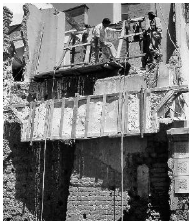
El friso mayor del salón ya el suelo, cubierto con el tablero protector de madera, cinchado con flejes.
