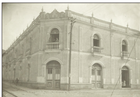
Edificio del colegio- 1915 Parece que María está en el balcón. Colección fotográfica X. Medinacelli.
